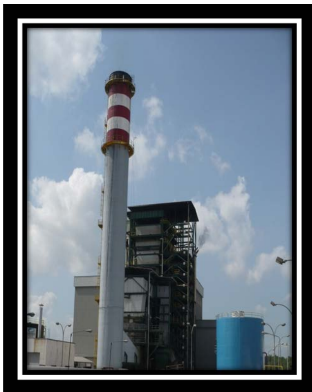
Ilustración 1. Central Térmica Trinitaria.
