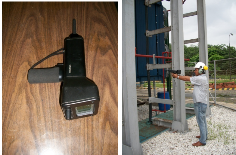
Ilustración 15. a) Equipo Ultrasonidos b) Prueba en el transformador
